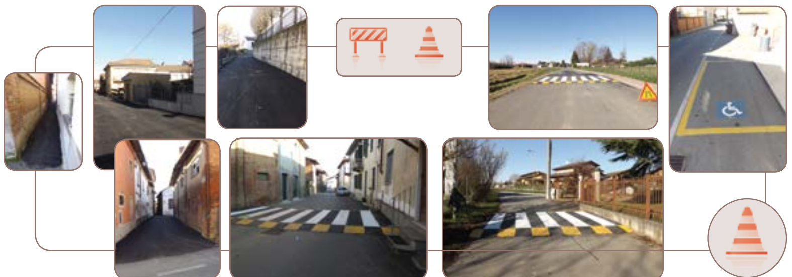
asfaltatura via Piave, parte vicolo Schelini, attraversamenti pedonali in via Garibaldi e via Kenney, segnaletica orizzontale e verticale
