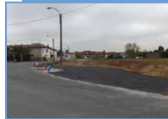
intervento sulla SP 50 che attraversa Quargnento
